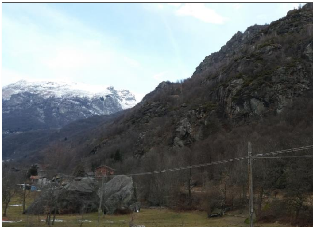
Figura 17 – Massi di crollo immediatamente a valle della strada provinciale.
